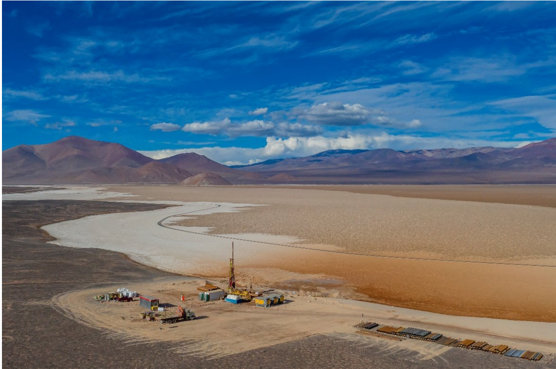
Plataforma Dual Rotary en operación de alta montaña.
