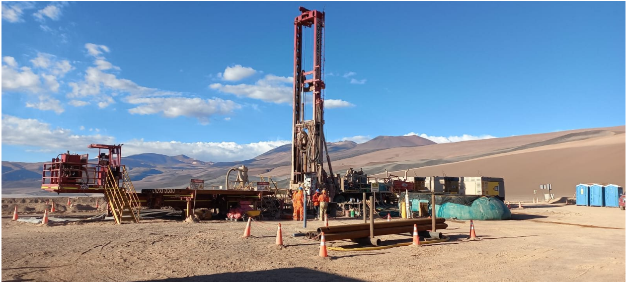
Montaje de plataforma en faena de cordillera.
