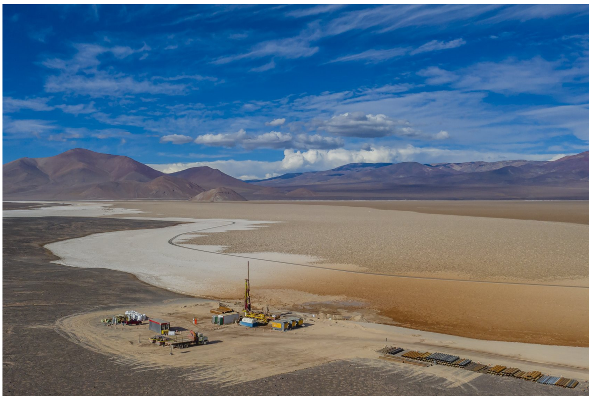
Plataforma de perforación Dual Rotary en operación de alta montaña.
